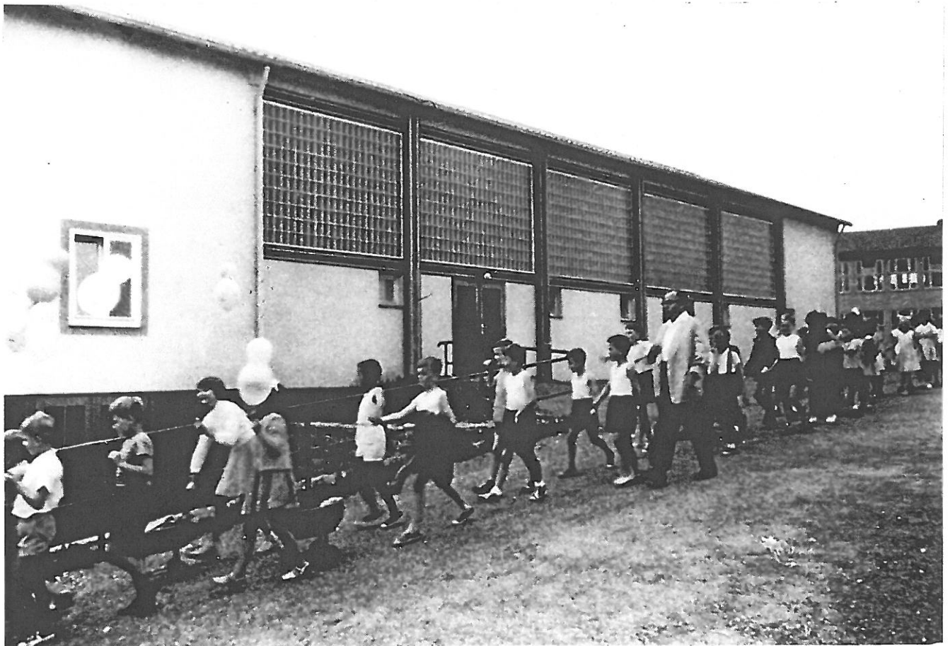
Abb. 16 Die 1954 - 56 erbaute Turnhalle
